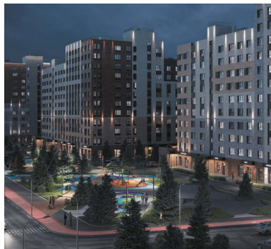
ПРЕОБРАЖЕНСКИЙ г. Новый Уренгой Класс жилья: Комфорт Объем строительства: 89 637 м² Количество домохозяйств: 809 Годы строительства: 2023 – 2026
