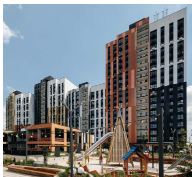
ИНСТЕП КРАСНОЗНАМЕННАЯ г. Воронеж Класс жилья: Комфорт Объем строительства: 34 660 м² Количество домохозяйств: 435 Годы строительства: 2021 – 2025
