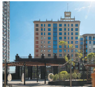
АЙВАЗОВСКИЙ г. Тюмень Класс жилья: Бизнес Объем строительства: 592 500 м² Количество домохозяйств: 4 512 Годы строительства: 2018 – 2027
